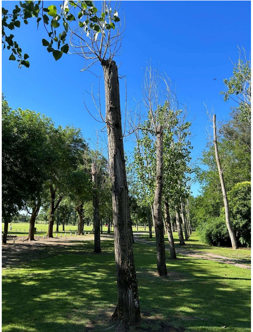
Se observan ejemplares secos a causa de las malas prácticas de poda (desmoche), cancros y desprendimiento de corteza.
